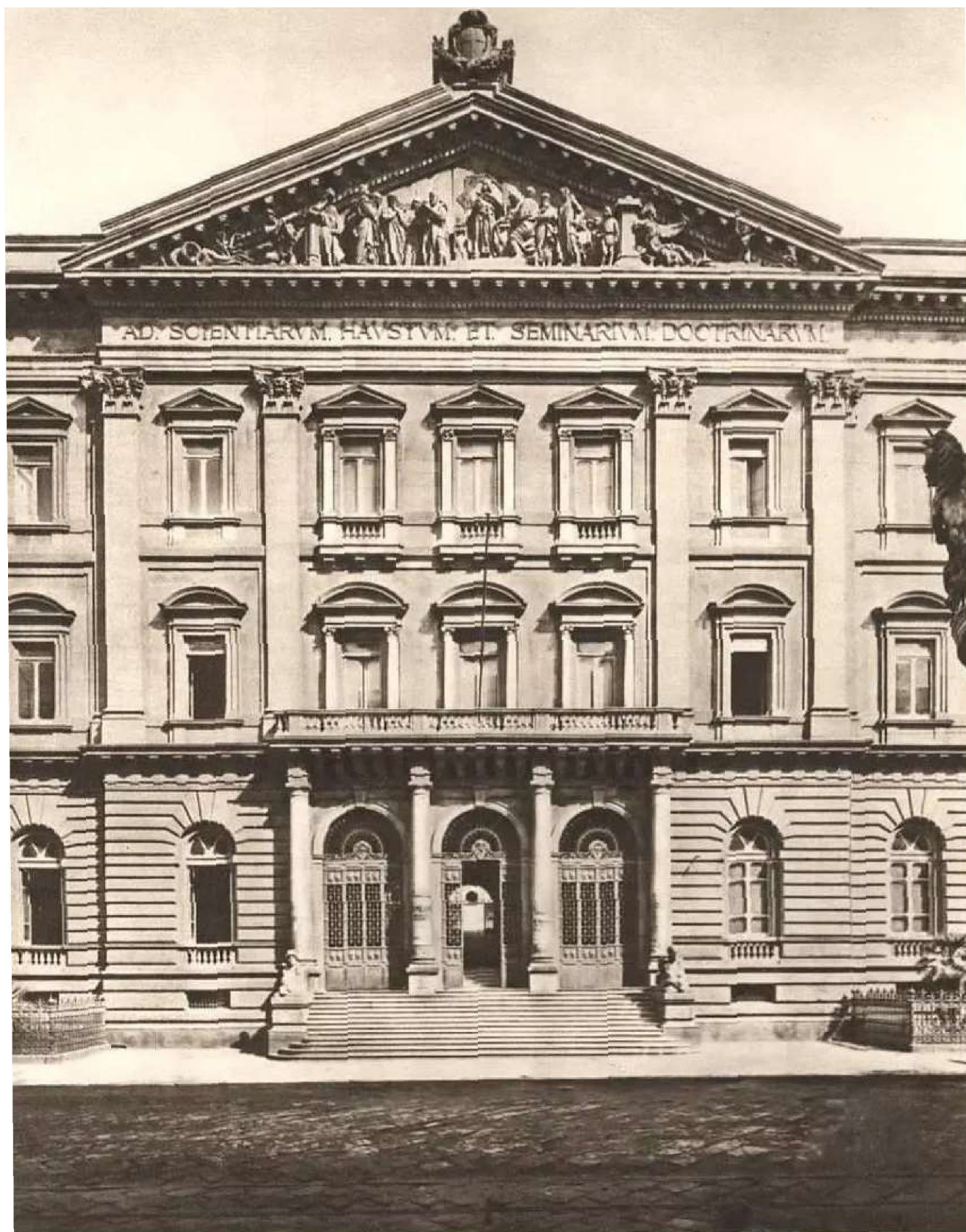
LA NUOVA UNIVERSITA • L'INGRESSO PRINCIPALE (Arch, PIER PAOLO QUAGLIA e GUGLIELMO MELISURGO , 1897• 908)
