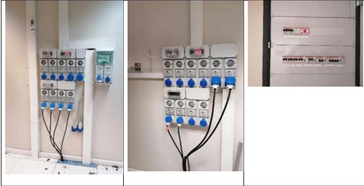
È presente un pavimento rialzato (15 cm), un quadro elettrico con prese industriali, un UPS Riello trifase da 40.000 VA, un impianto di condizionamento.
