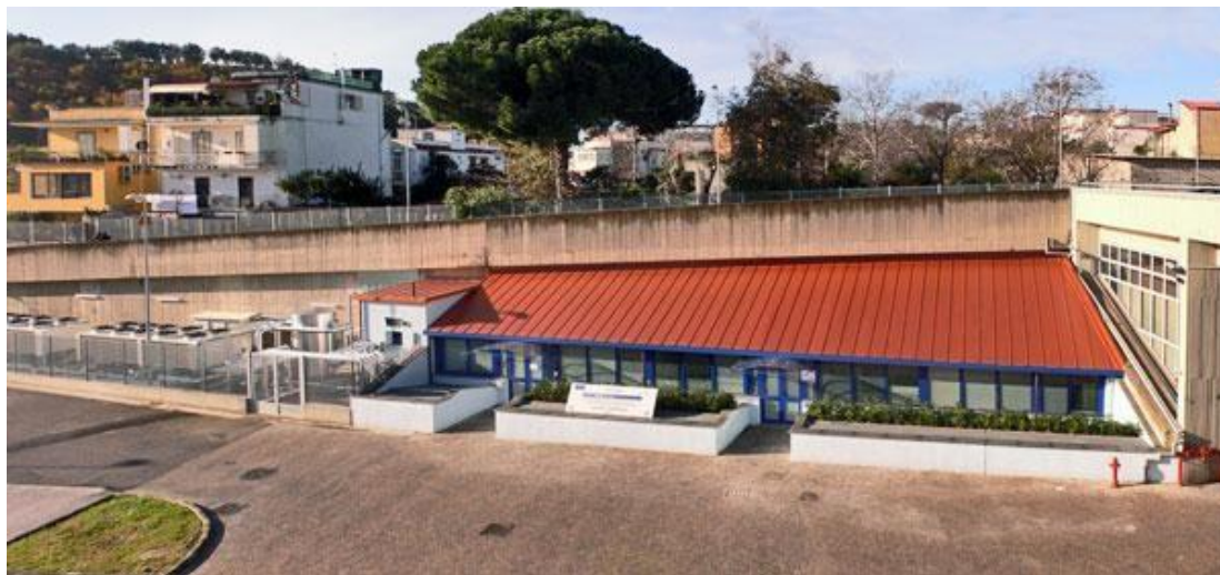
Figura 2: il Data Center SCoPE nel quale andrà effettuata la fornitura e l'installazione
