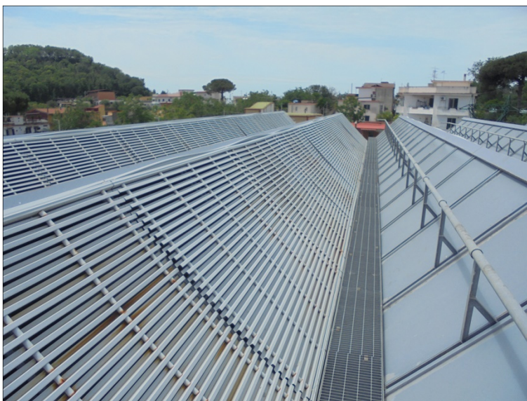
Figura 2 Vista complessiva di frangisole, lastre, corrimano e passerella
