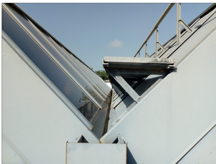
Figura 3 Canale di gronda, passerella e corrimano
