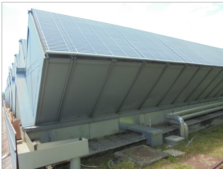
Figura 12 Vista lato ovest e vista canale di gronda protetto da strati in lamiera
