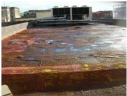
terrazzo copertura poliuretanic... 7° piano scal...
