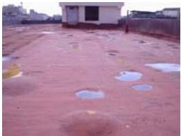
terrazzo copertura poliuretanic... scala A foto 1
