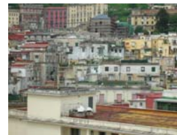
panoramica coperture foto 7
