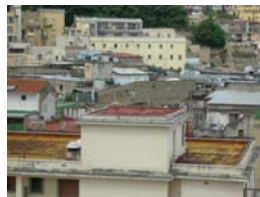
panoramica coperture foto 6
