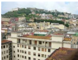
panoramica coperture foto 5
