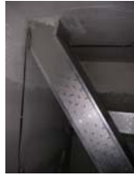
sottotetto torrino scala C
