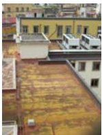
panoramica coperture foto 4
