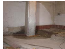
sottotetto torrino scala B
