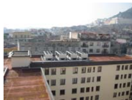
panoramica coperture foto 1
