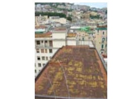
panoramica coperture foto 8
