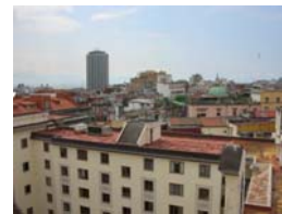
panoramica coperture foto 2
