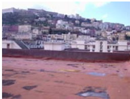
terrazzo copertura poliuretanic... scala A foto 2
