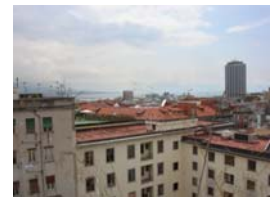
panoramica coperture foto 3
